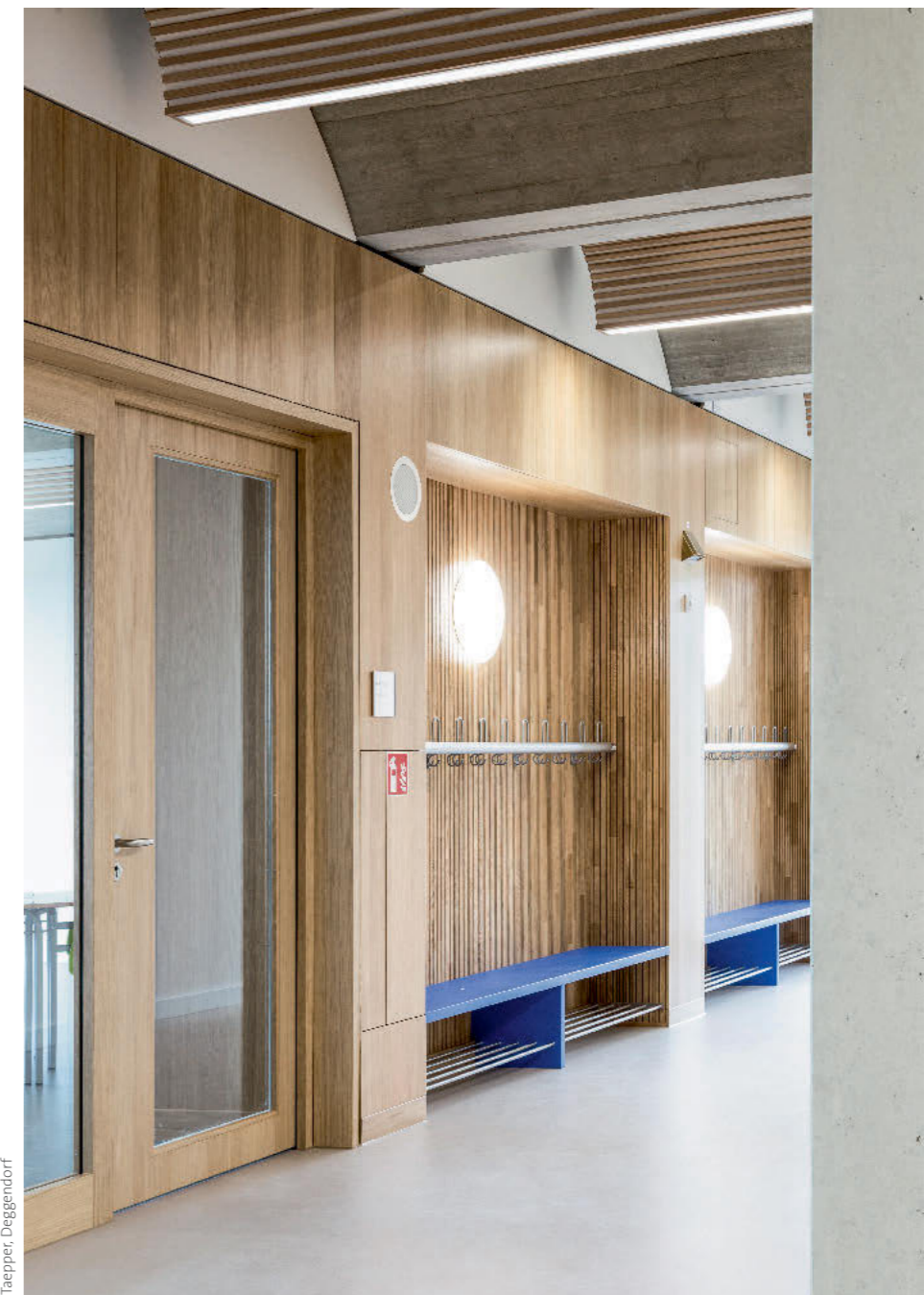
! Eine besondere Atmosphäre in den Klassenräumen schaffen die aus Beton geformten Tonnengewölbe der Decken, die um zusätzliche Absorberelemente mit integrierten Lichtbändern ergänzt wurden. Wie in den Klassenräumen, bestehen auch die Wandverkleidungen im Flur aus Feinmicro-perforierten Eiche-Echtholzpaneelen.
